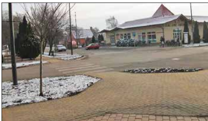
A településközpont korszerűsítése befejeződött
