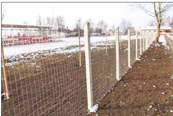
A sportpályán kerítésépítés és fásítás történt
