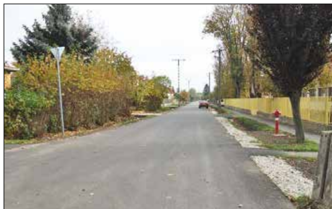
Béke utcai útépités és csapadékvíz-elvezetés
